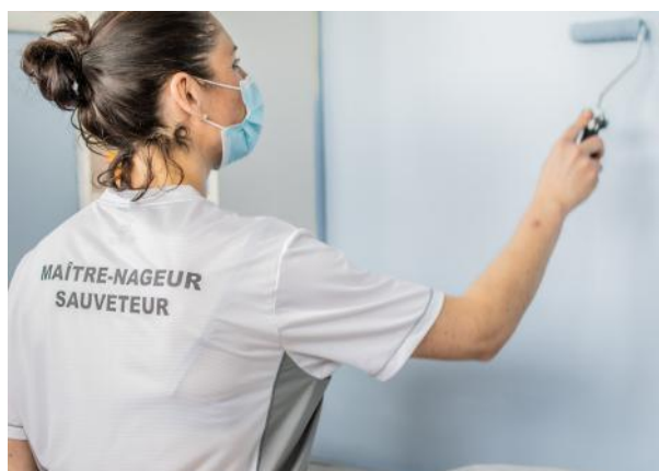
Ici Sophie repeint le mur de la salle des maîtres-nageurs.
