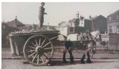
Émile Lampe 12 ans en 1949 sur la charette de l'entreprise de transport
