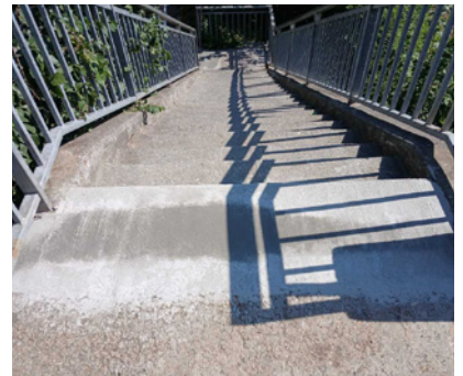
Rénovation de l'escalier de la Passerelle
