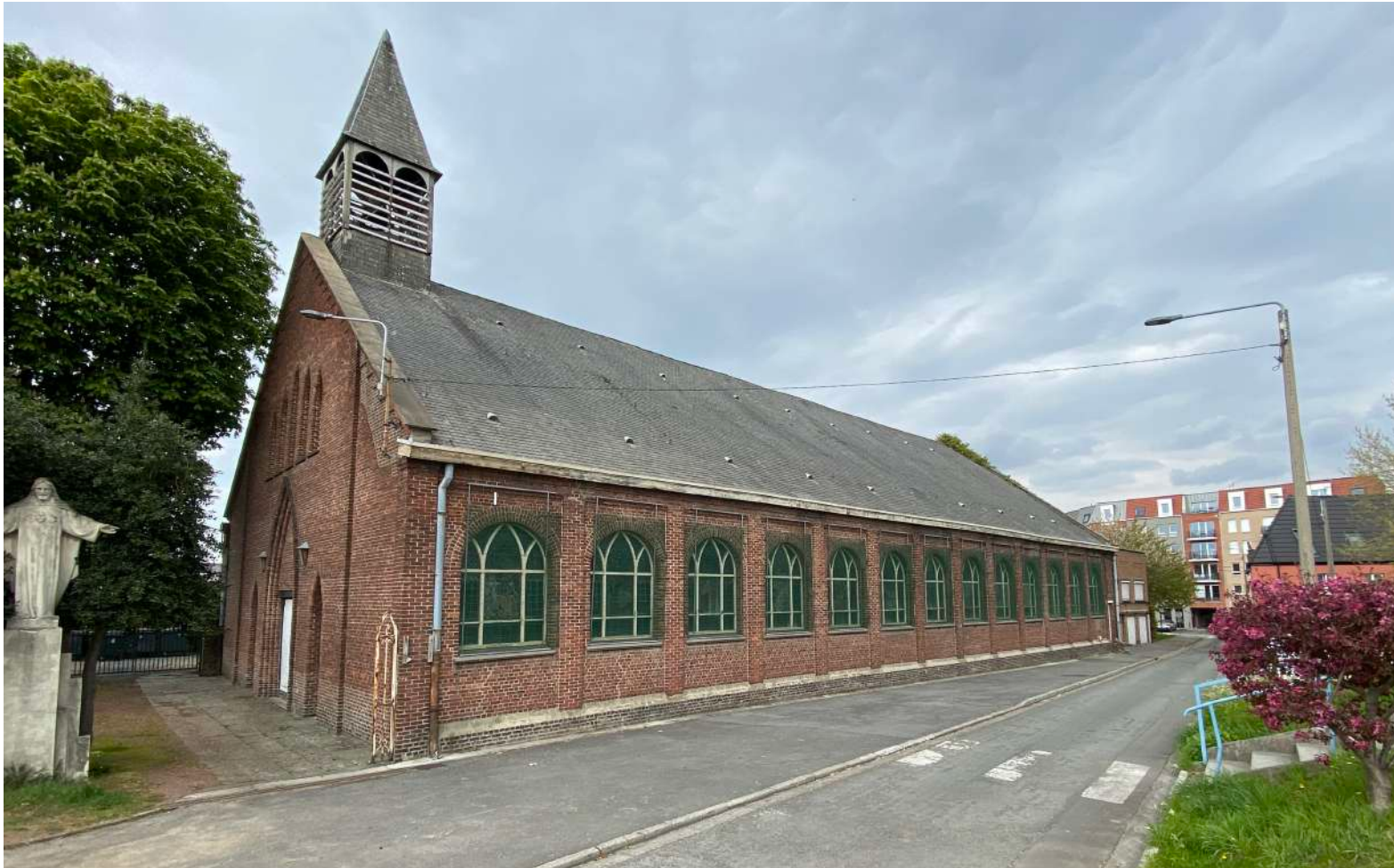
Photos de l'existant
