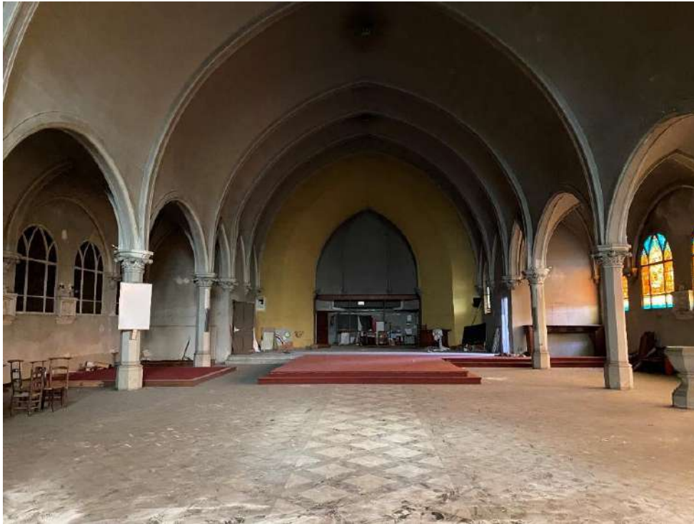
Photos de l'existant
